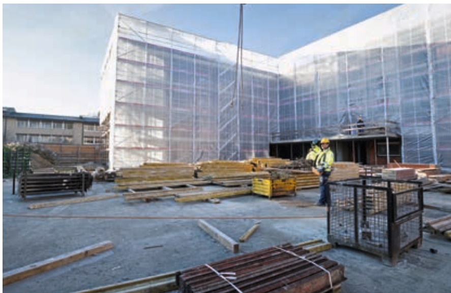
Wie geplant: Der Rohbau ist schon seit Weihnachten 2016 abgedeckt.
