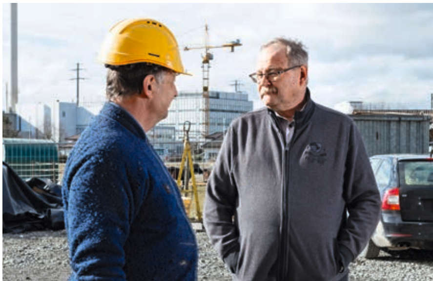
«Seine» Baustelle: Fast täglich kontrolliert und koordiniert Heinrich Huber die Arbeiten an der Nussbaumallee.
