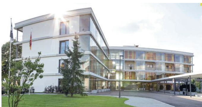
Der Neubau des Alterszentrum Alenia in Gümligen.
